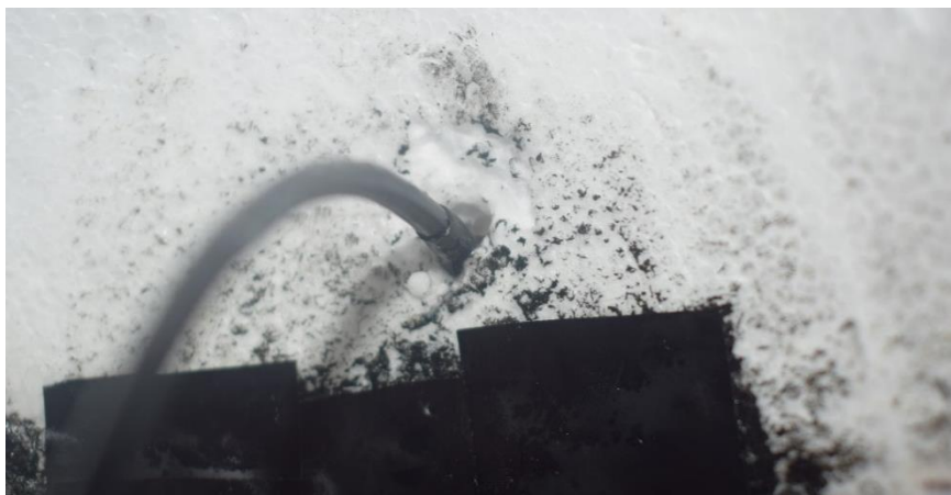
Figura 136 Perforación antena WSPR
